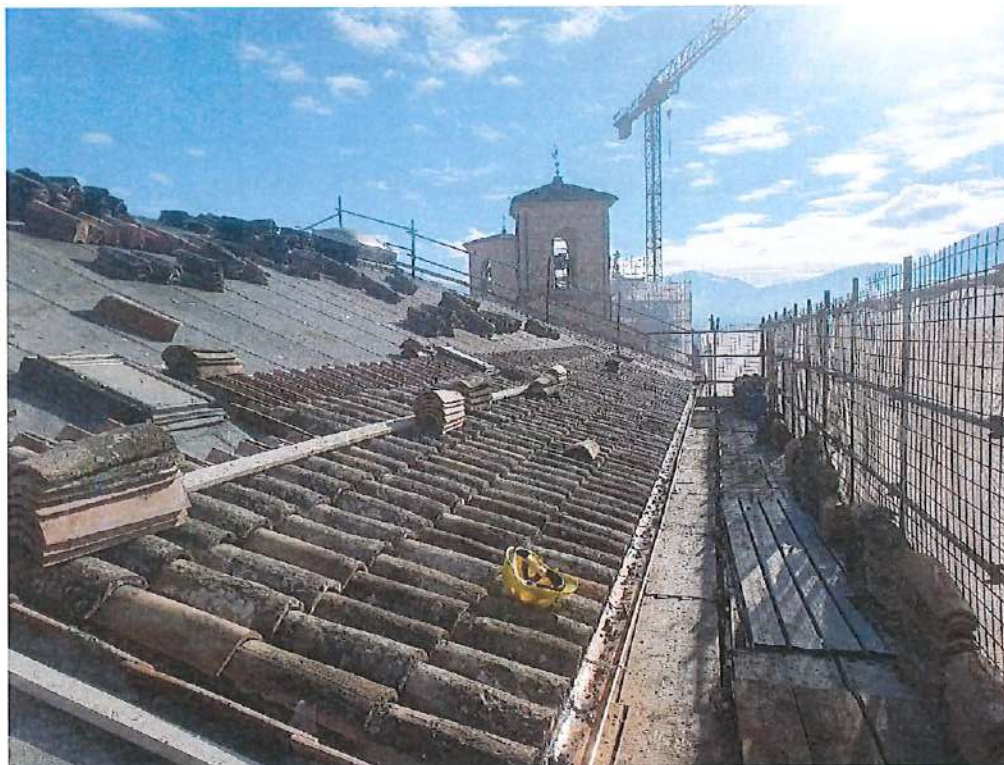
Fig. 1 - Intervento in copertura da completare
