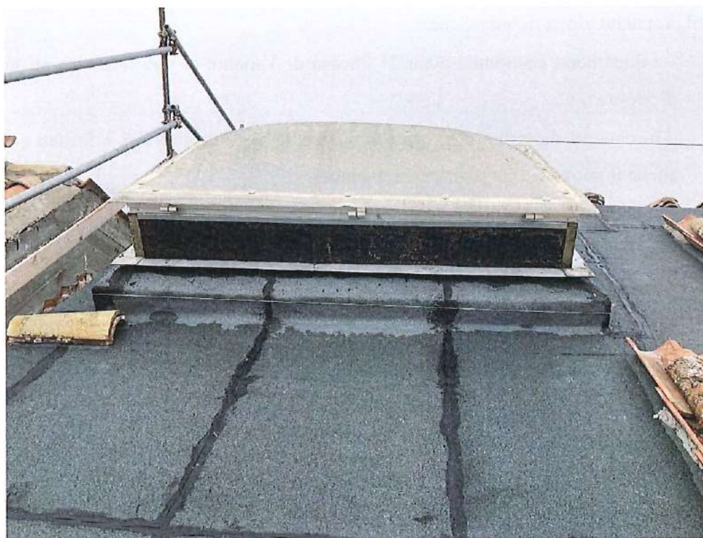
Fig. 2 - Intervento in copertura da completare
